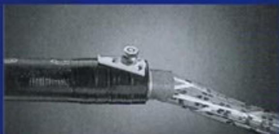
Die Lasche des Kabelmantels wird mit Isolierband bis ca. 10 mm über das Laschenende hinaus isoliert. Die Abdeckplatte ist nun mit der breiten Seite zur Mantelöffnung mittels einer selbstsichernden Mutter zu fixieren. Dadurch ergibt sich gleichzeitig die Fixierung der Grund- und Kontaktplatte im Kabel.
