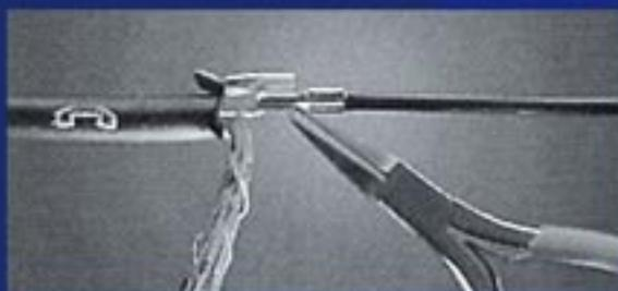
Die Schirmverbindungsklemme wird mit einer Zange am Kabelmantel zwischen den Adern und der Kabelmantel-Innenseite angesetzt.
